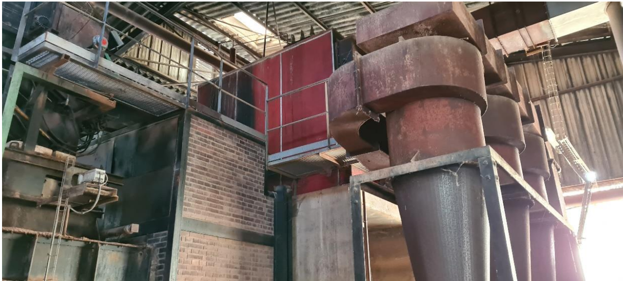
Photographie 4 : Vue de l'étuve et du broyeur, aperçu des murs et de la toiture du bâtiment n°1
