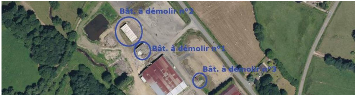
Photographie 1 : Vue aérienne des trois bâtiments à démolir
