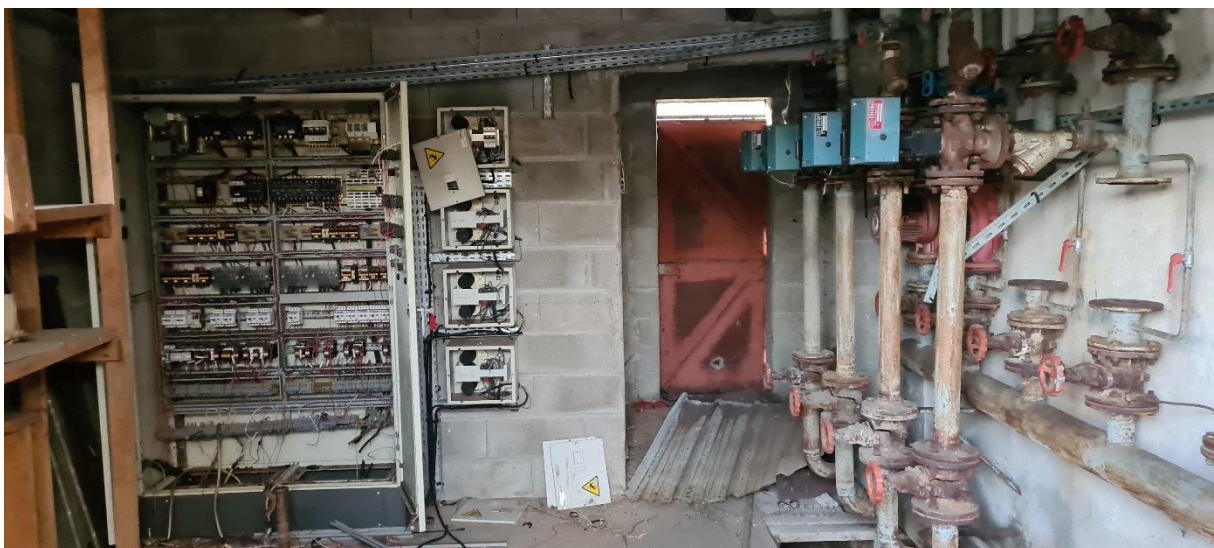
Photographie 5 : Vue du local technique du bâtiment n°2
